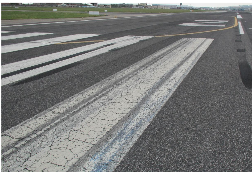
Foto 4: strisce di vernice blu della coda del B738 marche YR-BMM in corrispondenza della soglia pista 24.
