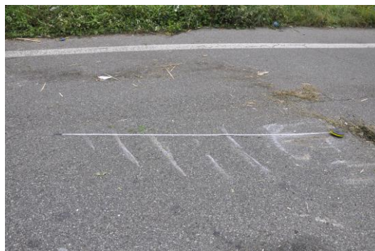
Foto 9: impatti pale elica su asfalto rampa immissione SS671.
